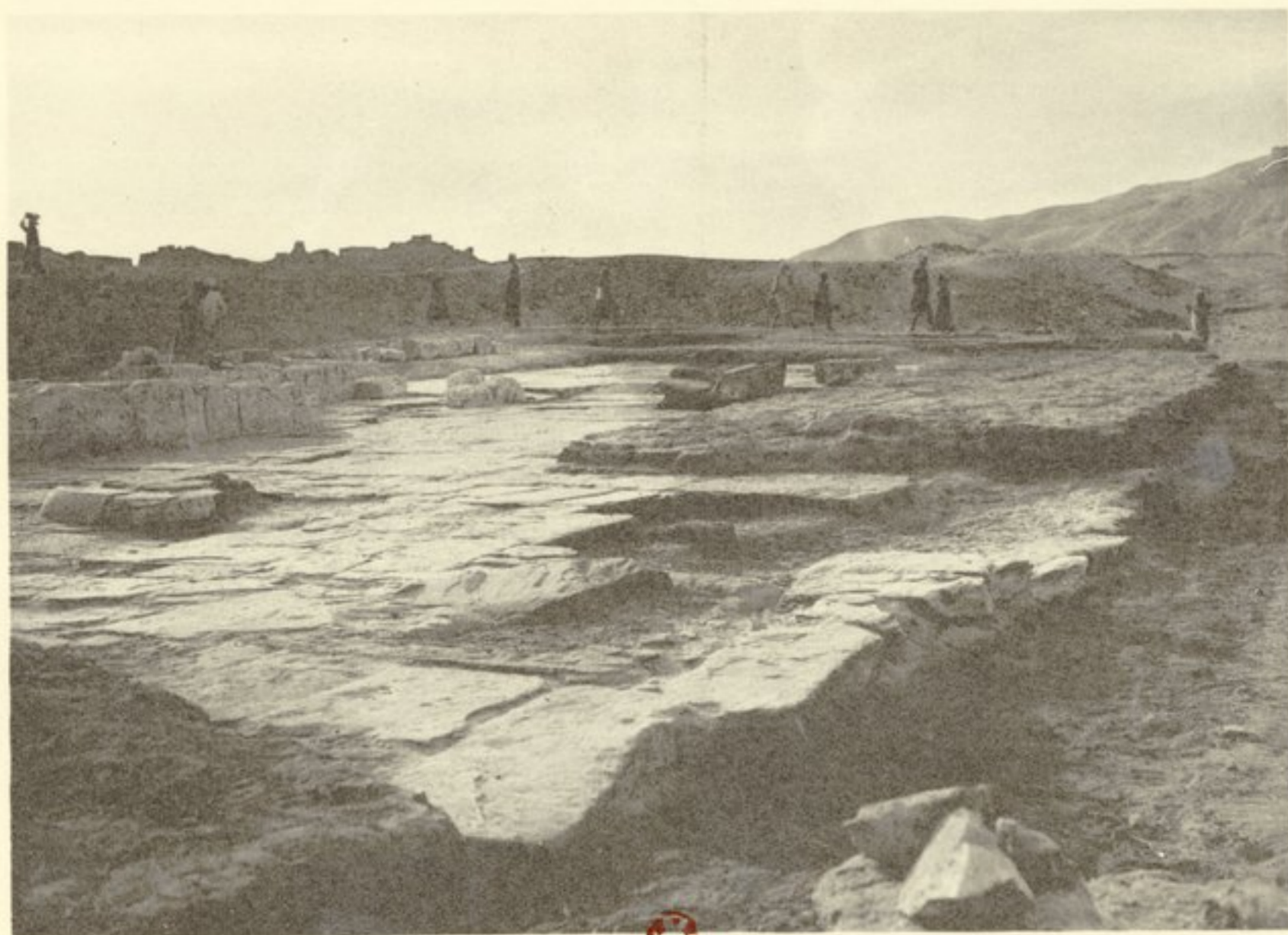
28. — Tronçon de l'enceinte Sud passant sur les fondations du temple de Thoutmès II.
