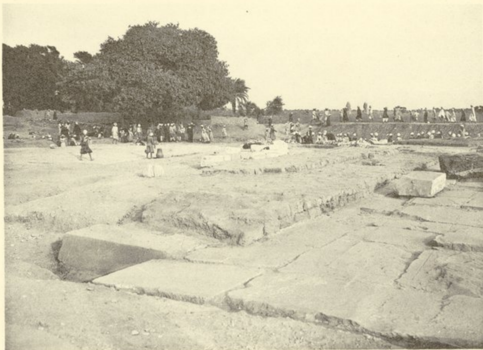
27. — Tronçon de l'enceinte Sud passant sur les fondations du temple de Thoutmès II.
